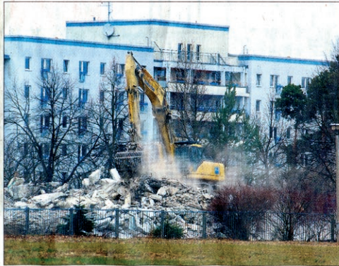
Die abgerissene Kästner-Grundschule im WK X gibt den Blick auf das Laurentius-Haus frei. Fotos: Uwe Schulz (2)
