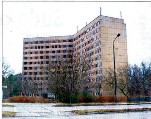
Der wegen seiner Grundform Y-Hochhaus genannte Elfgeschosser wird jetzt für den Abriss vorbereitet. Die ersten Fenster sind schon ausgebaut.
