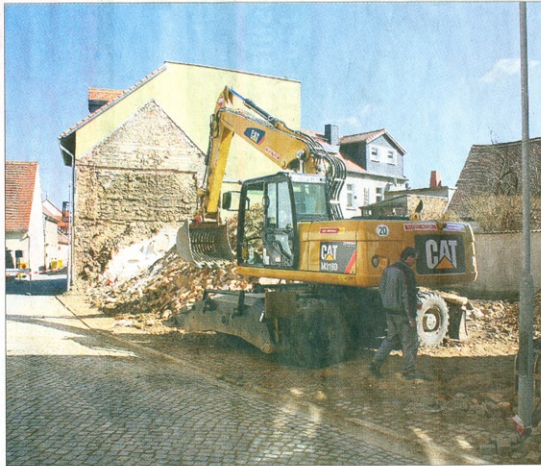
Gestern um 12.45 Uhr waren beide Gebäude beseitigt. Die Arbeiter waren schneller, als vorab vermutet. Komplett beräumt und gesichert ist das Areal aber noch nicht. Foto: Hagen Linke
