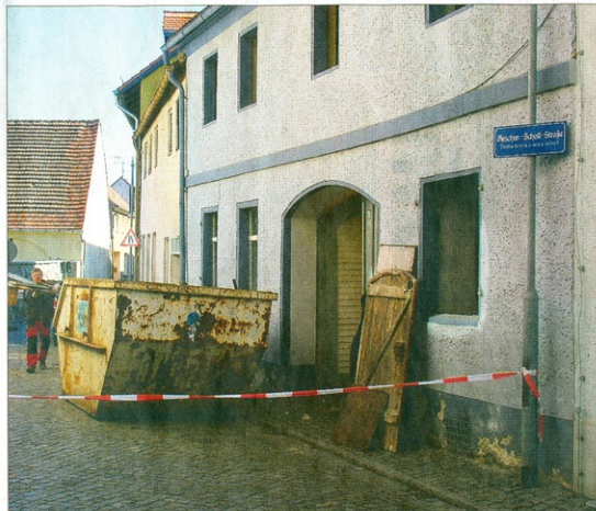
So sah es am Montag dieser Woche um 10:15 Uhr zum Frühlingsanfang in der Scholl-Straße 2 (vorn) aus. Das Gebäude und Haus Nr. 4 (dahinter) standen kurz vor dem Abriss. Foto: Uwe Jordan
