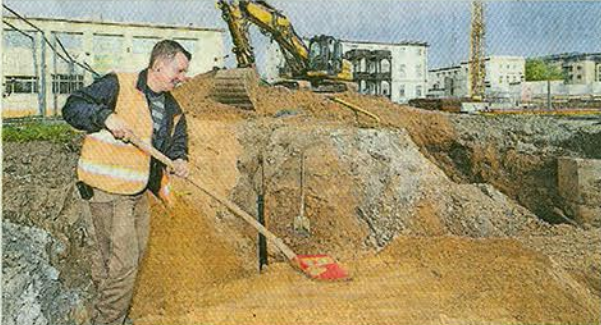
Baggerfahrer Tobias Schulz hatte die Bombe am Vortag gefunden. Nun schaufelt er Sand auf die nahegelegene Gasleitung - als Schutz während der Sprengung.
