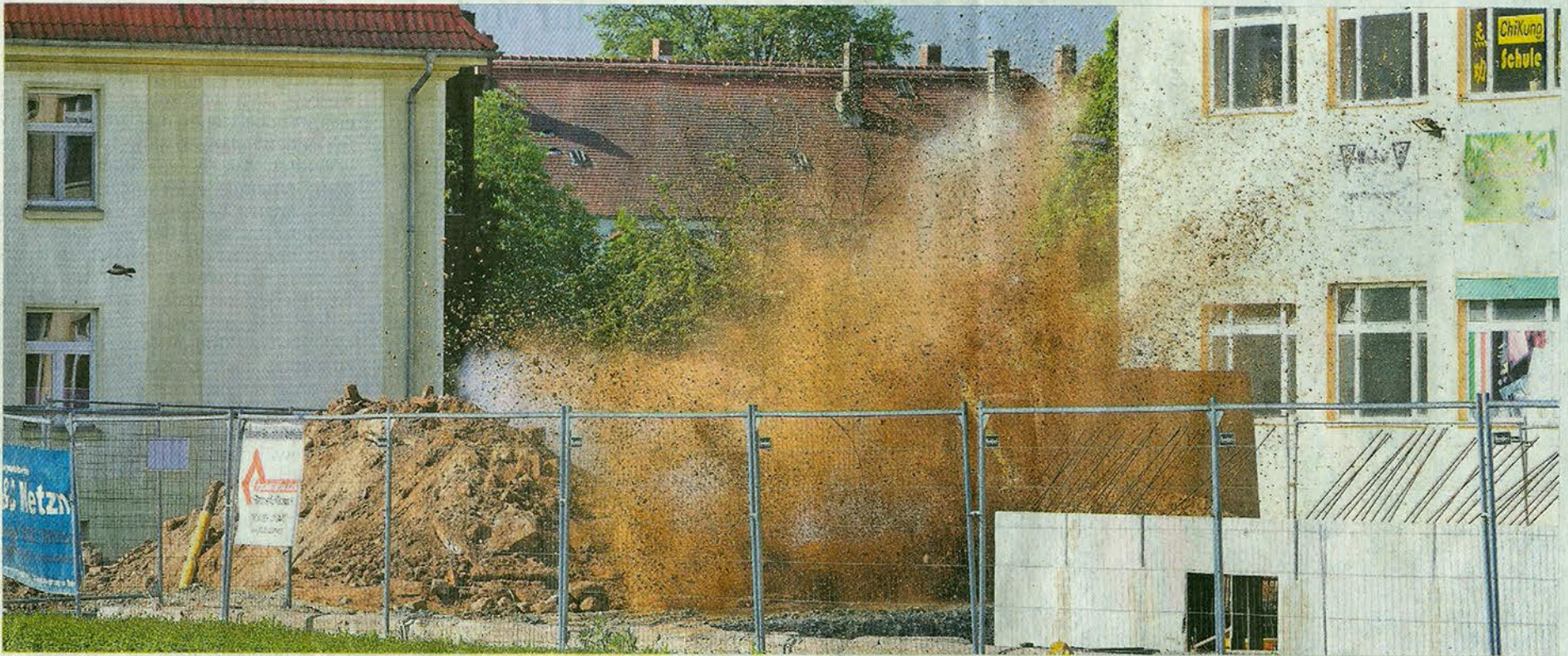
Etwas Erde fliegt in die Luft, das war's: Auf dem Gelände der Baustelle für ein Wohn- und Geschäftshaus an der Bautzener Paul-Neck-Straße wurde am Freitagvormittag eine Brandbombe unschädlich gemacht. Weil der Sprengkörper aus dem Zweiten Weltkrieg weder transportiert noch entschärft werden konnte, wurde er vor Ort gesprengt. Fotos: Steffen Unger
