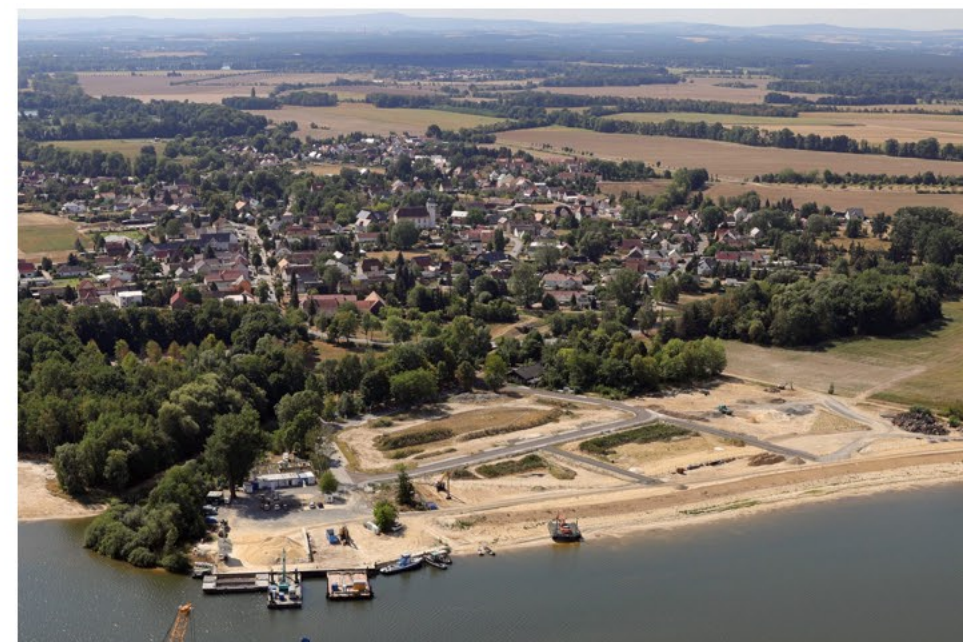
Fläche des neuen Vereinszentrums am Knappensee/Groß Särchen
