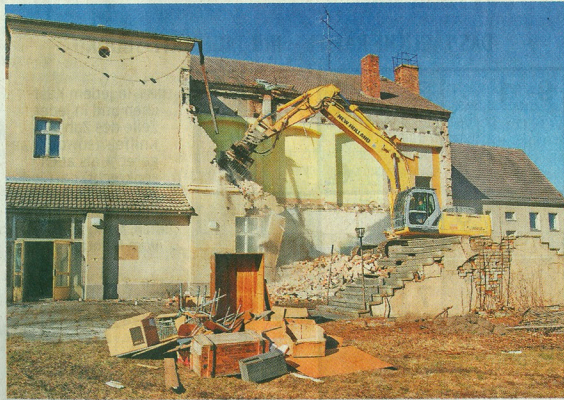
Vor mehr als drei Jahren begannen mit dem Abriss des maroden Ost-Anbaus die Arbeiten an der Braugasse. Sie werden sich nun in die Länge ziehen. Foto: Mirko Kolodziej
