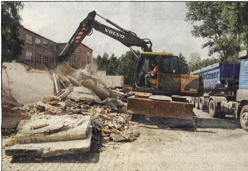
Das Werkengebäude in Burgneudorf wurde vorgestern abgerissen. Foto: Menzel
