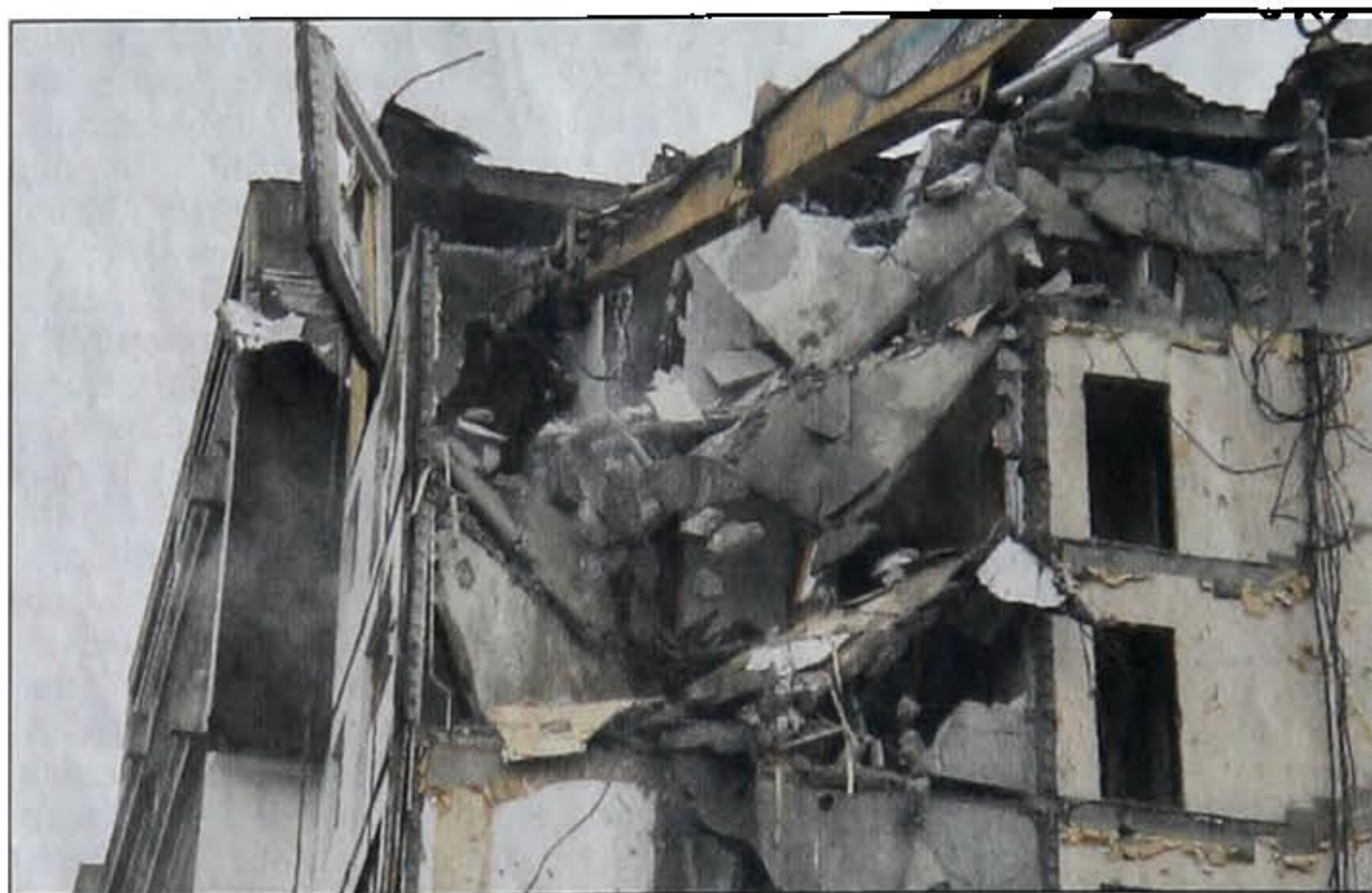
Die Greifzange zerlegt die Betonteile mit einem Druck von 25 Tonnen.
