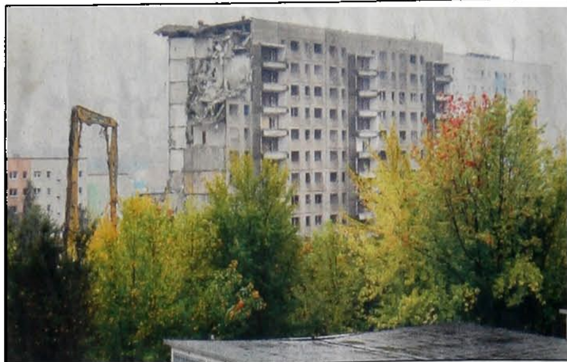
So zeigt sich das Abrisshaus in Bautzen-Gesundbrunnen aus Richtung Autobahn. Der hintere Elfgeschoss ist bereits saniert und bleibt stehen.
